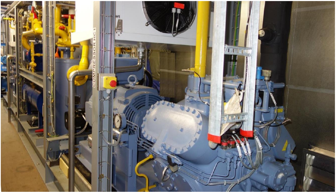
←LD→←WARMTEWISSELAARS→ ← ----- HOGE DRUK COMPRESSOR GRASSO ----- →
